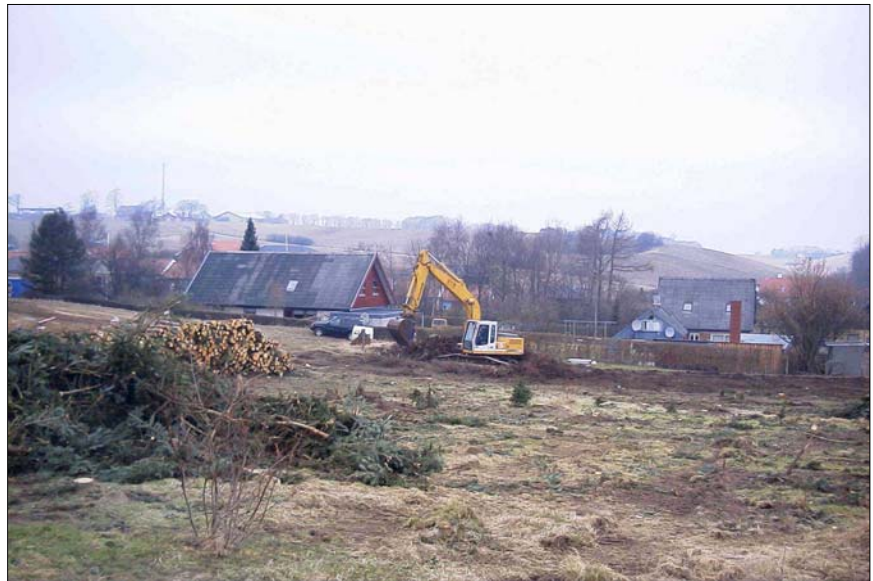
Gravearbejde ved byggemodning i nabo område
